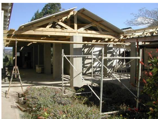
Der Bau des neuen Ambulatoriums schreitet voran
