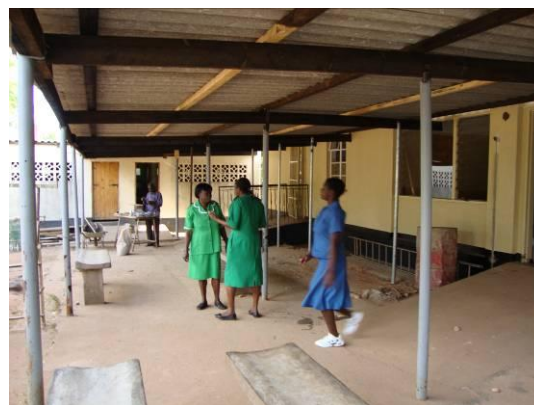
Die neue AIDS-Klinik (noch nicht ganz fertig gebaut)
