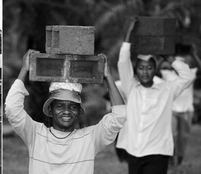
Bau des Bibliotheksgebäudes
