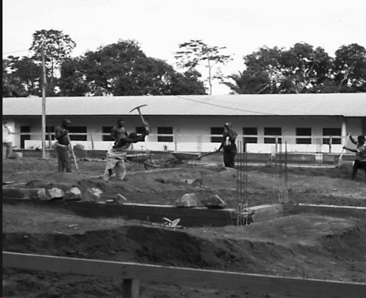
Bau des Bibliotheksgebäudes
